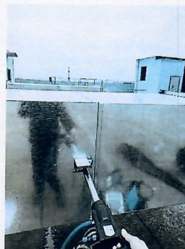
热厨 2 号排气筒
